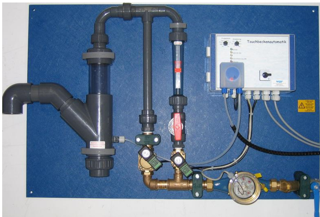
Автоматика бассейна для окунания с автоматическим наполнением, сливом, а также дезинфекцией
